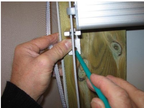
Fäll ner gardinen till önskat bottenläge, centrera linan och skruva fast vinkelgaffeln
