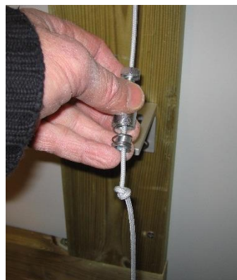
Anpassa detaljerna i vinkelgaffeln och knyt i botten för att fixera linan, klipp av överflödig lina
