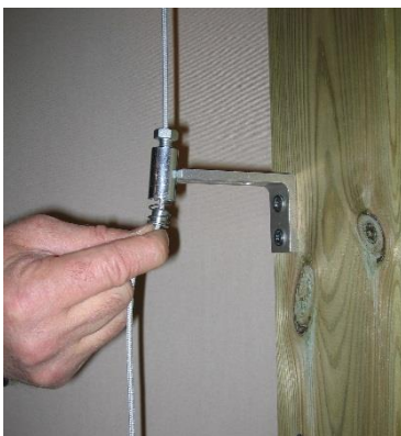
Anpassa detaljerna i vinkelgaffeln och knyt i botten för att fixera linan, klipp av överflödig lina
